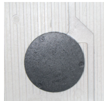
Zustand im Rohbau
