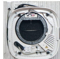
Lüftung im Kasten verbaut
